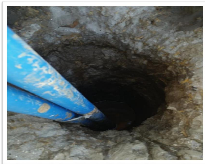
Figura 31 Proceso de generación pozos geotérmicos para proyecto Piloto Parque Industrial la Gran Sabana n°2. [46]
