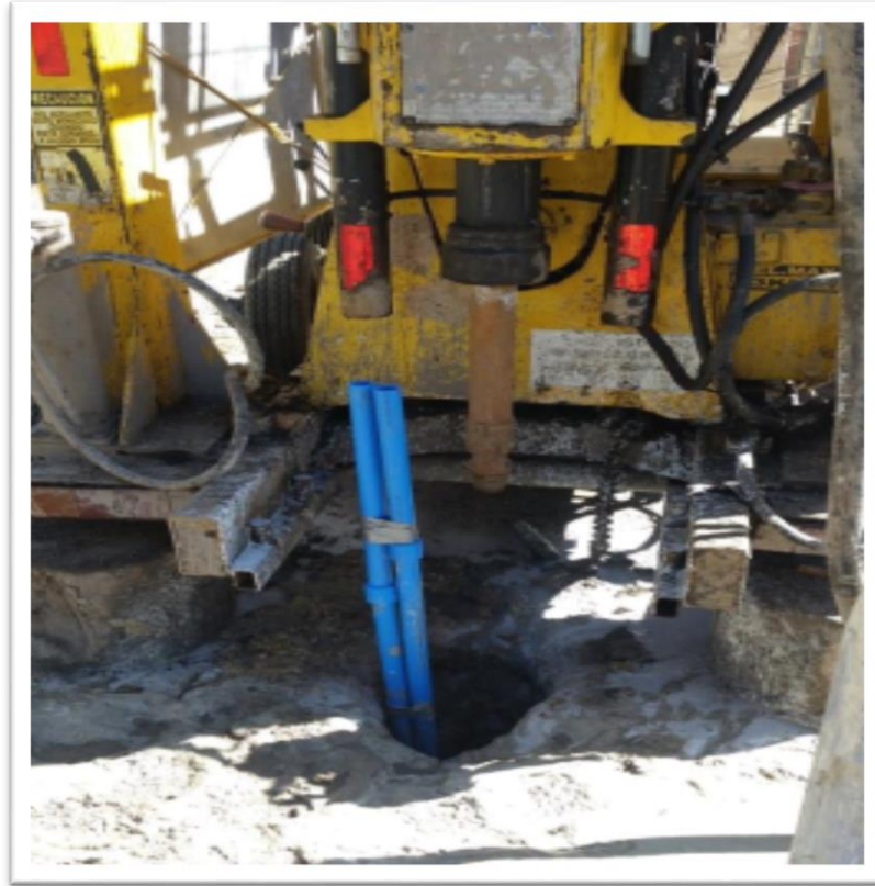
Figura 30 Proceso de generación pozos geotérmicos para proyecto Piloto Parque Industrial la Gran Sabana n°1. [46]
