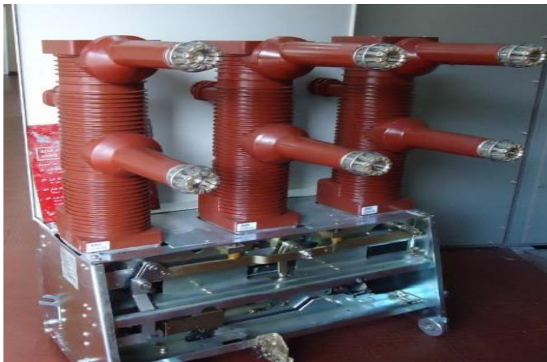
Figura 35 Interruptor en vacío tipo interior. Fuente: CHEC [6].
