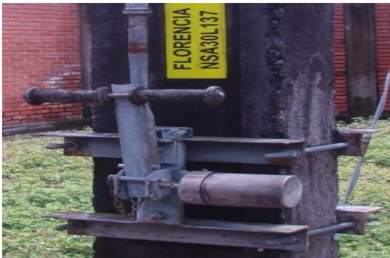
Figura 47 Accionamiento manual de un seccionador. Fuente: CHEC [6].
