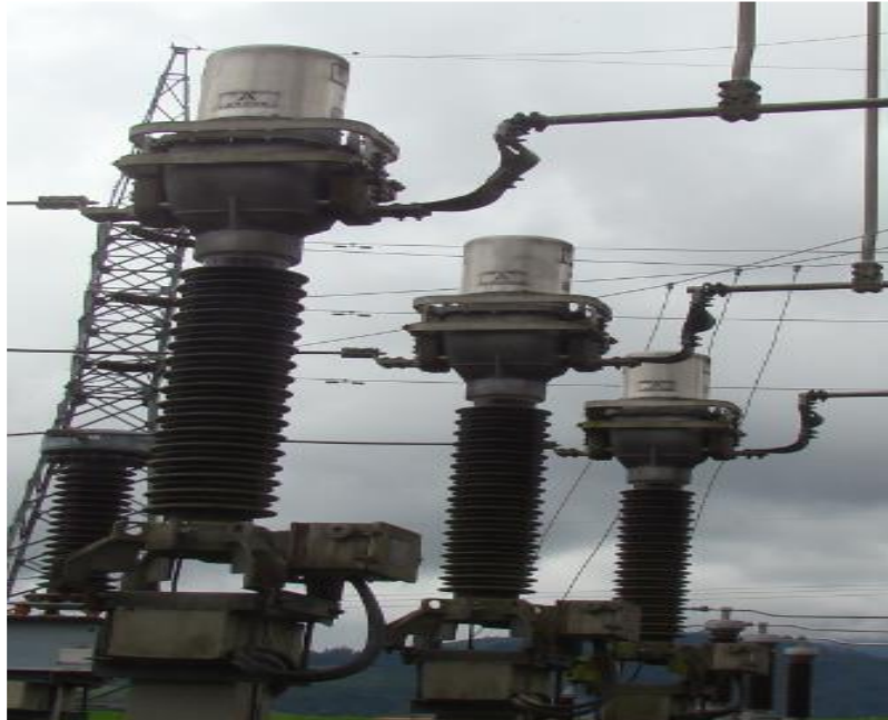
Figura 54 Transformador de corriente tipo devanado primario. Fuente: CHEC [6].
