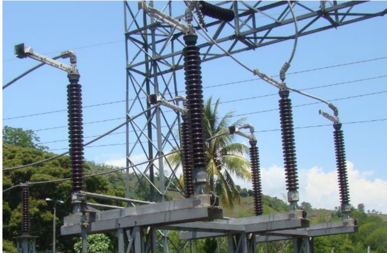
Figura 43 Seccionador de doble apertura central. Fuente: CHEC [6].
