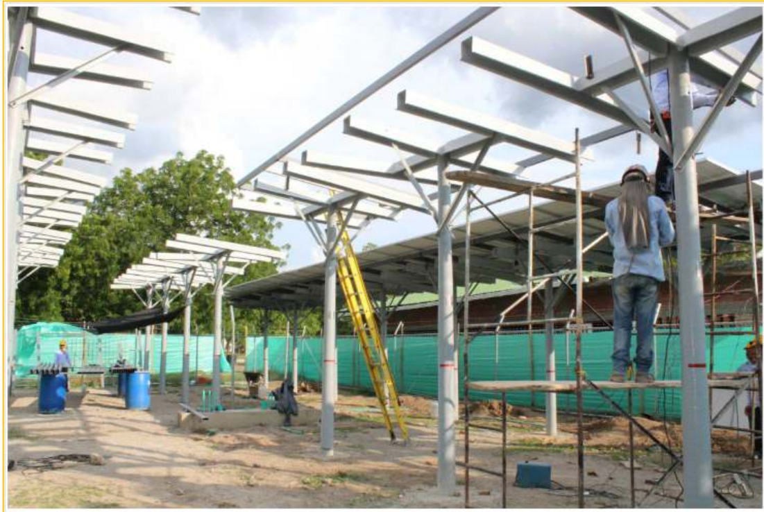
Ilustración 108 Instalación Paneles Fotovoltaicos Municipio Jerusalén. Fuente [67]
