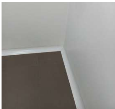
Figura 9. Uniones redondeadas de piso a pared.
