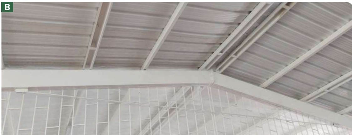
Figura 8. Techo con inclinación para reducir acumulación de suciedad. a. Externo; b. Interno.
