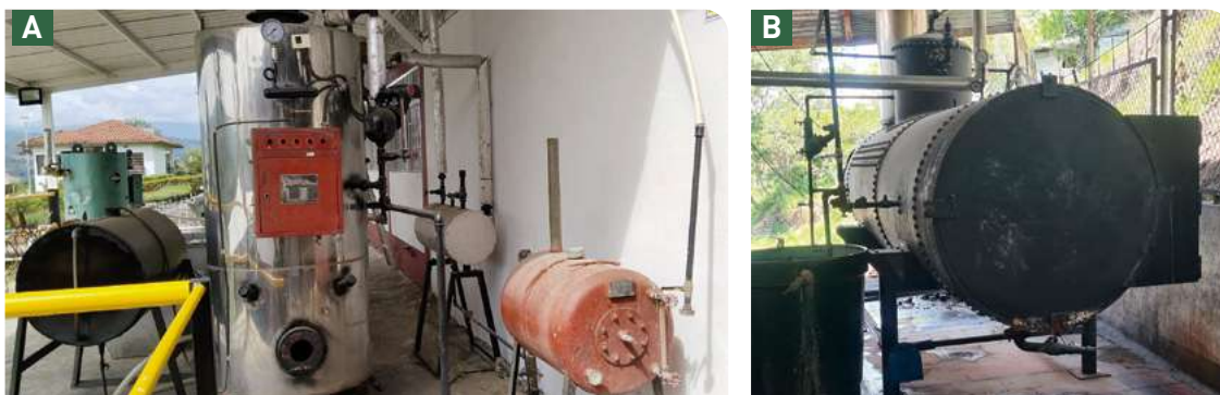
Figura 23. Calderas pirotubulares. a. Vertical; b. Horizontal.
