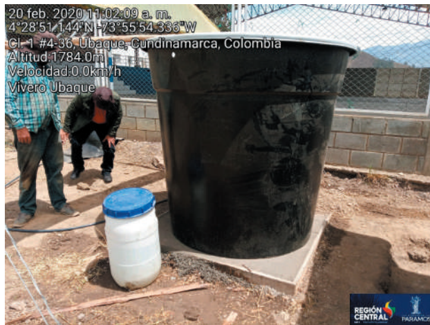
Montaje sistema de almacenamiento de agua y riego
