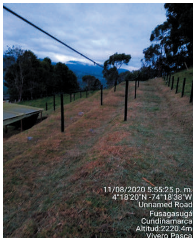
Sistema de riego (Izq) y área cerramiento en alambre de pua 12.5 (Der)
